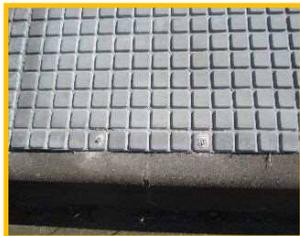
◆ 縁石とマルチマットを、小径アンカーで固定します。
