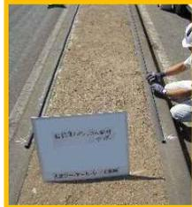
◆ 縁石とマルチマットの間に、超軟質スポンジゴム又はシリコンシーラントを施工します。
